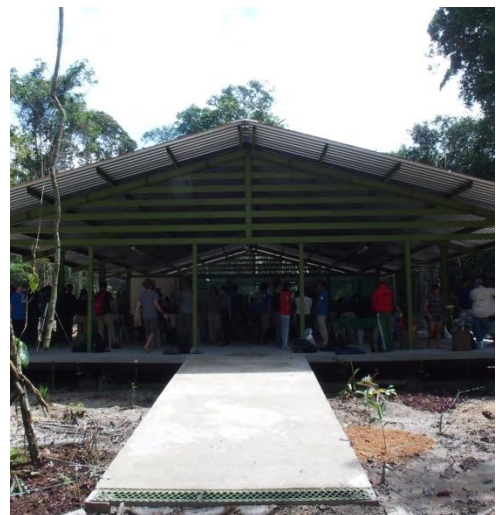
伊藤忠商事(株)からの寄付により 建設された多目的施設
